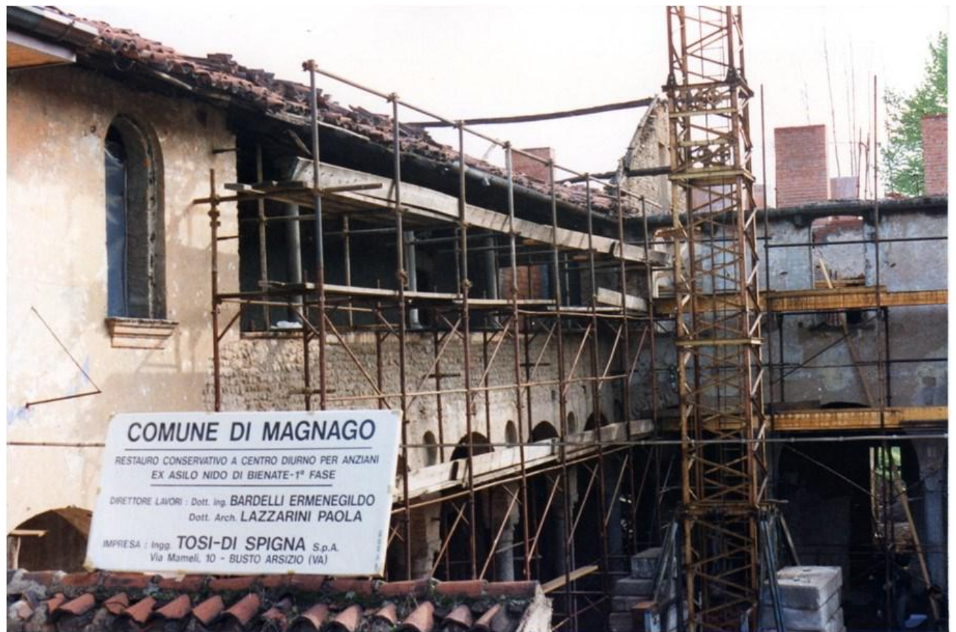
Bienate – Restauro del Vecchio Asilo.
