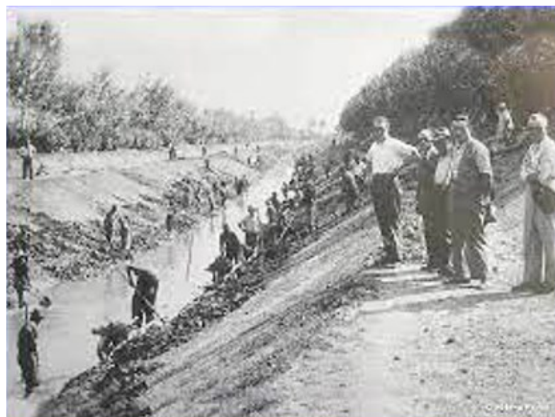
Lavori di scavo del Canale Villoresi
